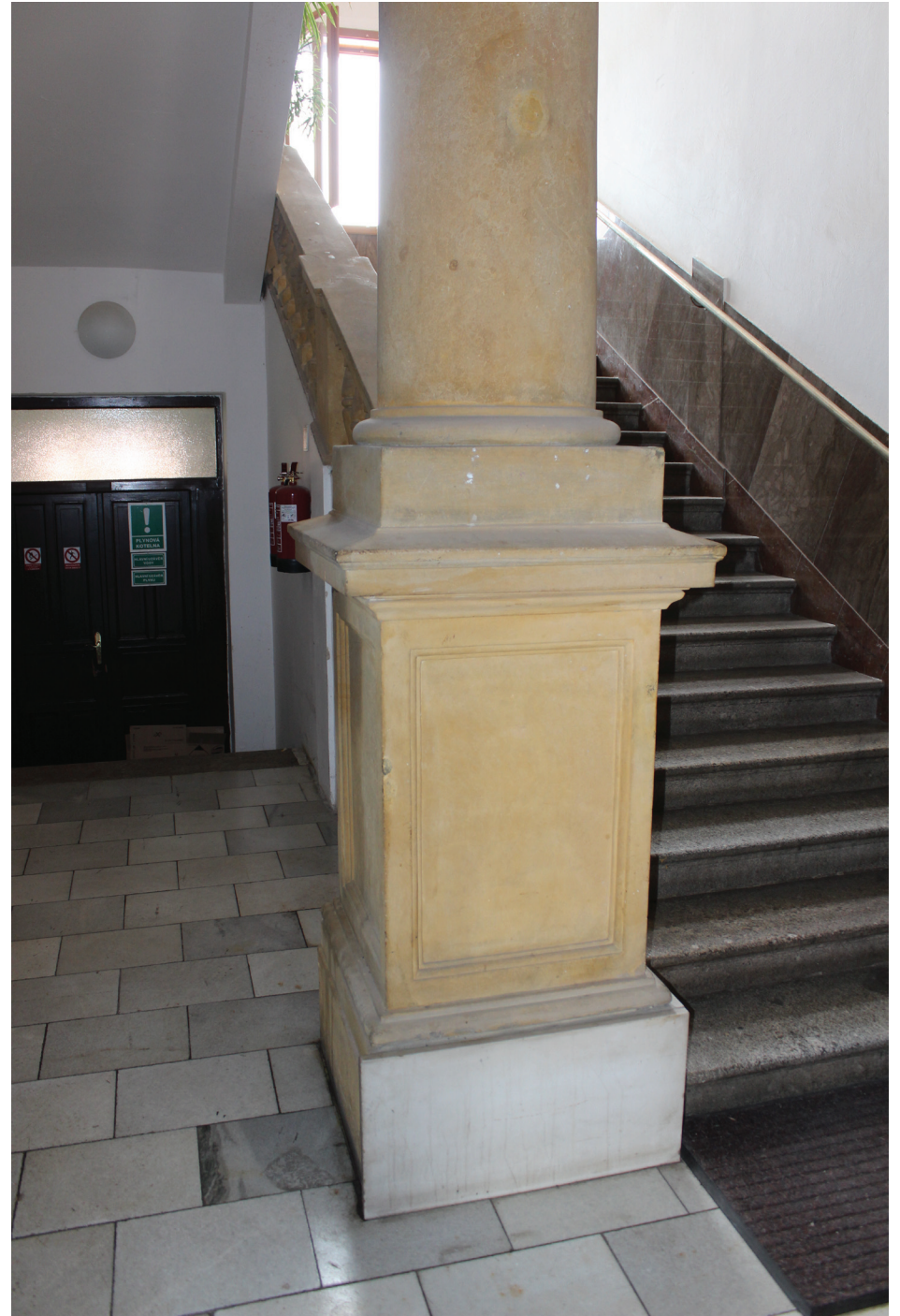
12. Detail stylobatu po levé straně vstupu na schodiště, patka zcela překryta druhotně osazenou deskou z bílého mramoru
