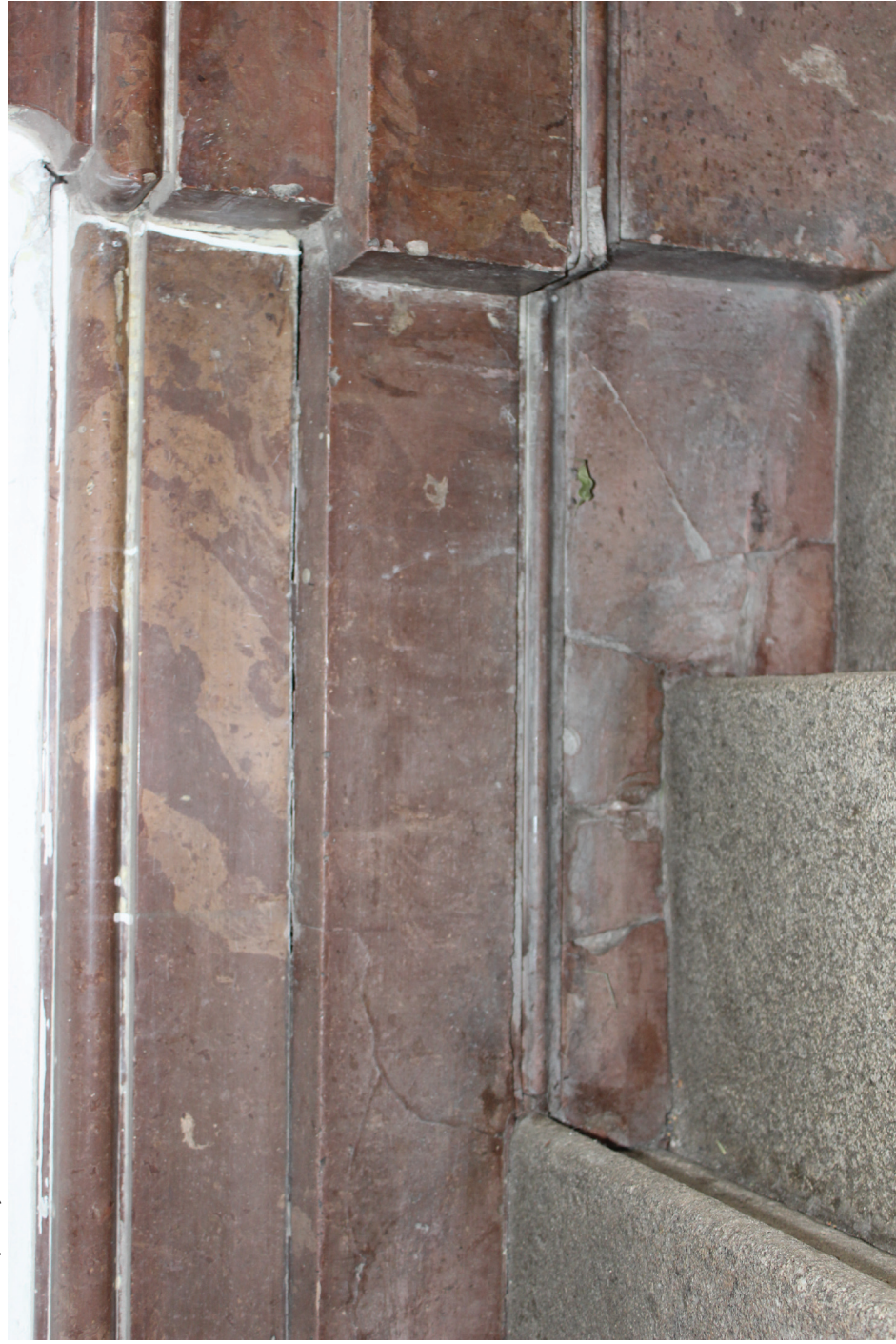
7. Pravá strana vstupního vestibulu, celkový pohled na obklad a částecně tažené prvky z umělého mramoru
