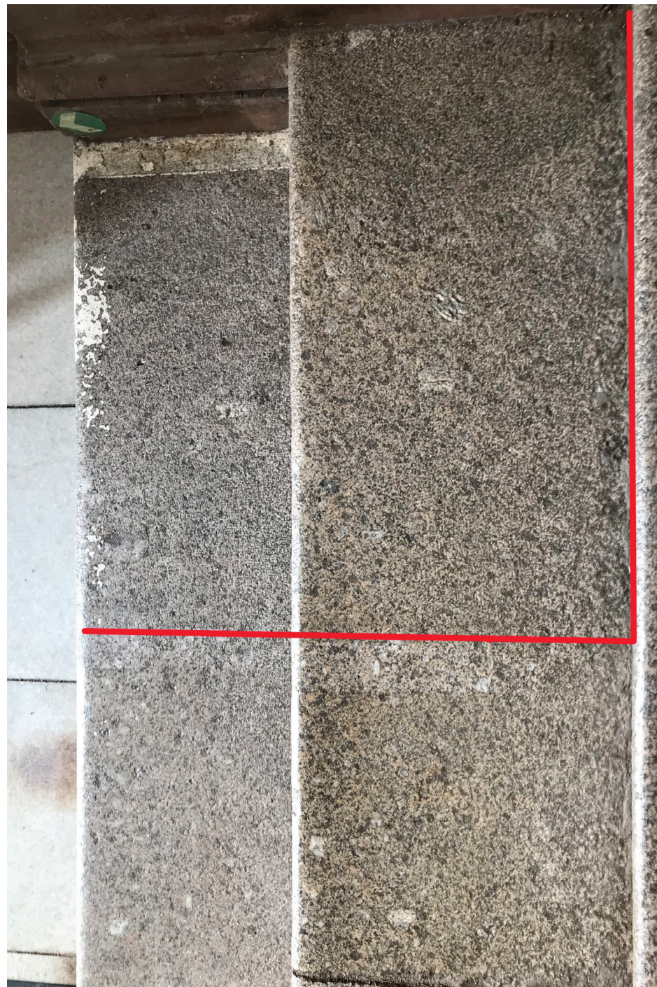
24. Zkouška čištění žulového schodiště vstupního vestibulu vodní párou s detergentem a mechanickým dočištěním. Nečistoty sejmuty z transparentním nátěrem uzavřeného povrchu
