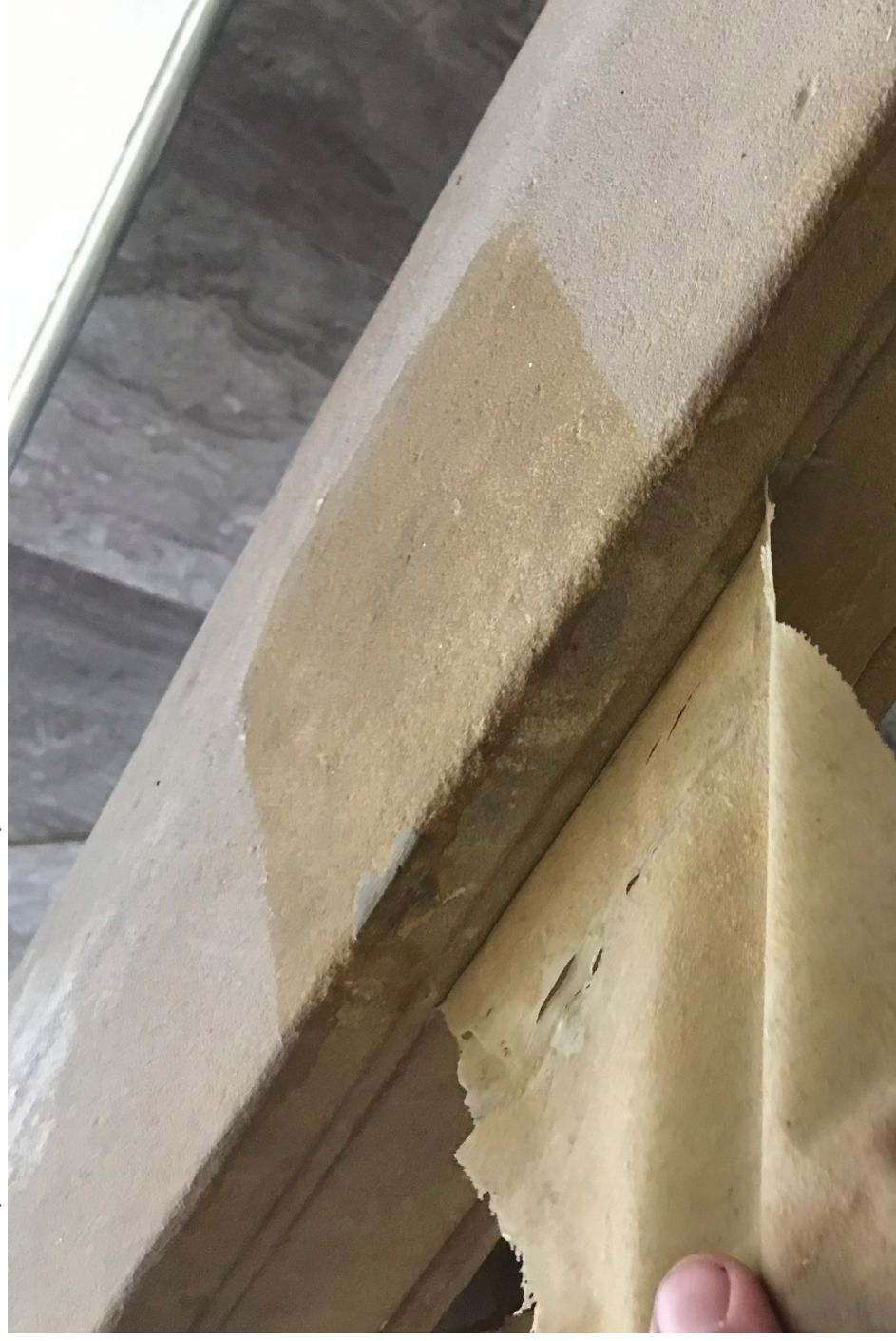
26. Čištění povrchu pískovce bez použití vody za pomoci peelingové metody, odstranění prachových depositů z povrchu madla balustrády
