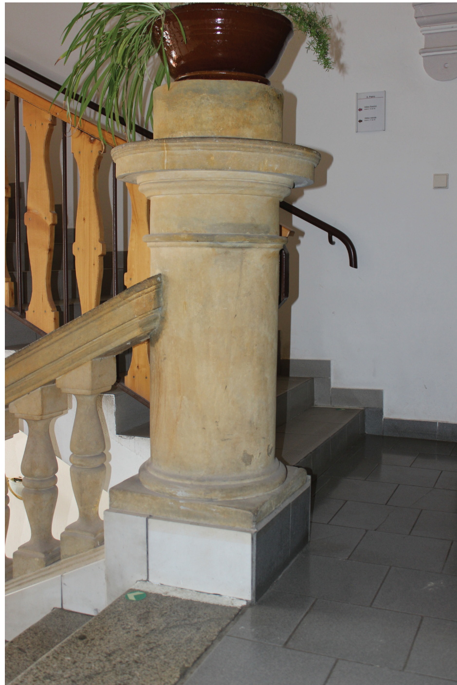
16. Druhý rotační sloup při vstupu do chodby 2 NP
