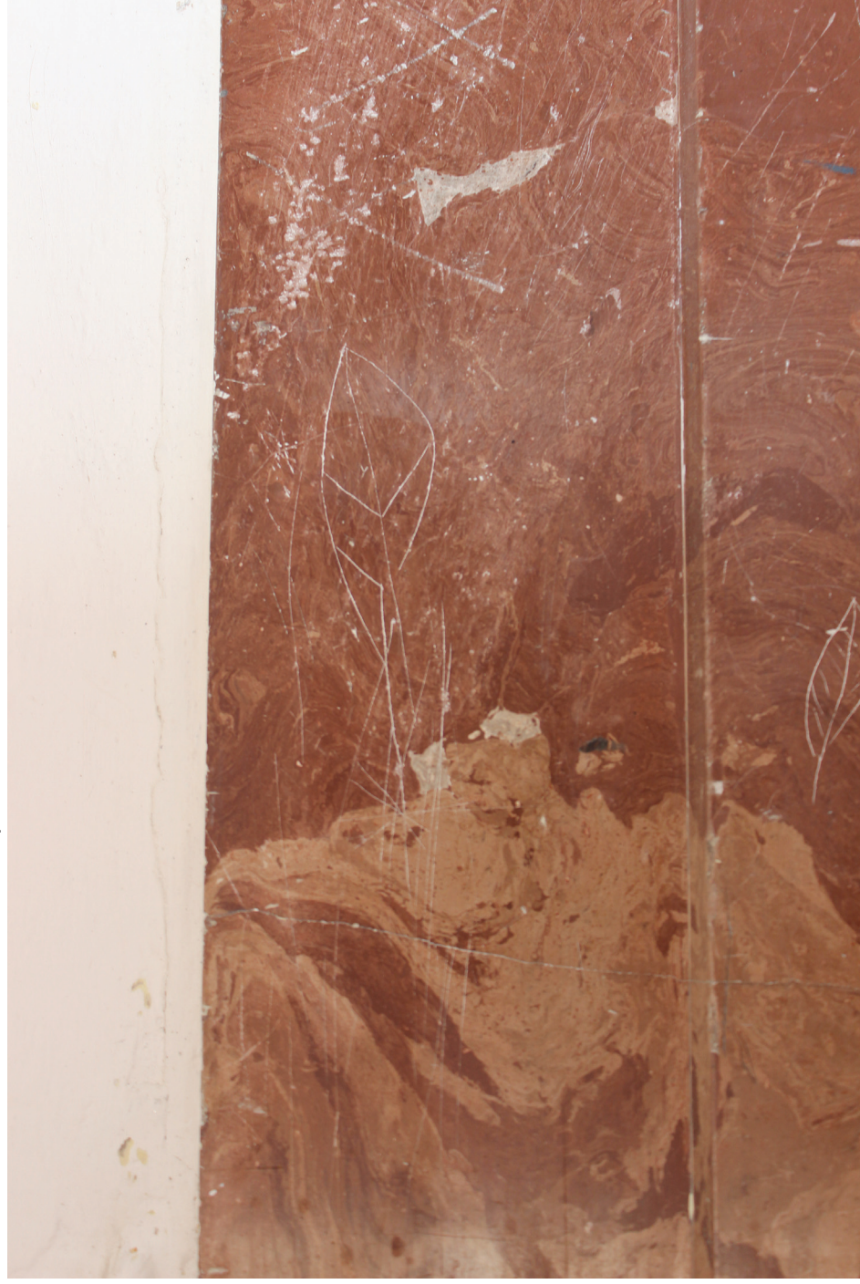
1. Zádveří hlavního vstupu do budovy, obklad soklu provedený z umělého sádrového mramoru, levá strana od vstupu
