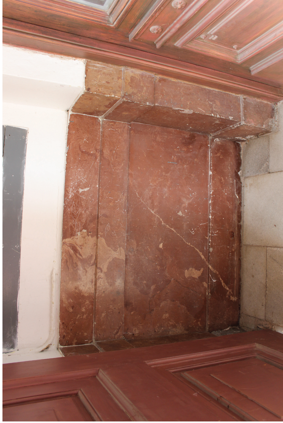
1. Zádveří hlavního vstupu do budovy, obklad soklu provedený z umělého sádrového mramoru, levá strana od vstupu
