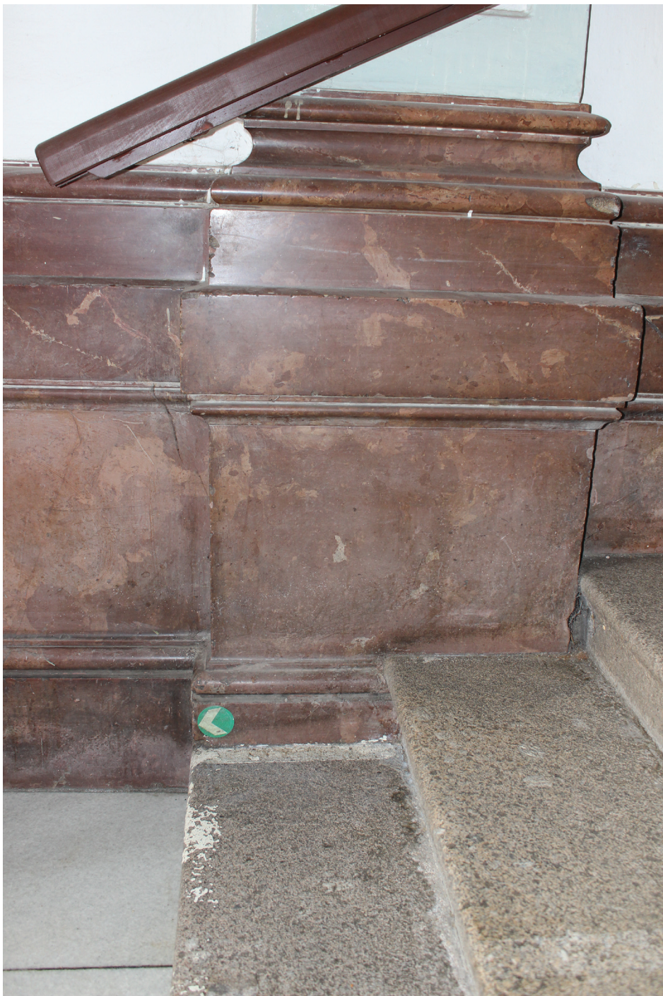
3. Vstupní vestibul, detail soklu pilastru z umělého mramoru
