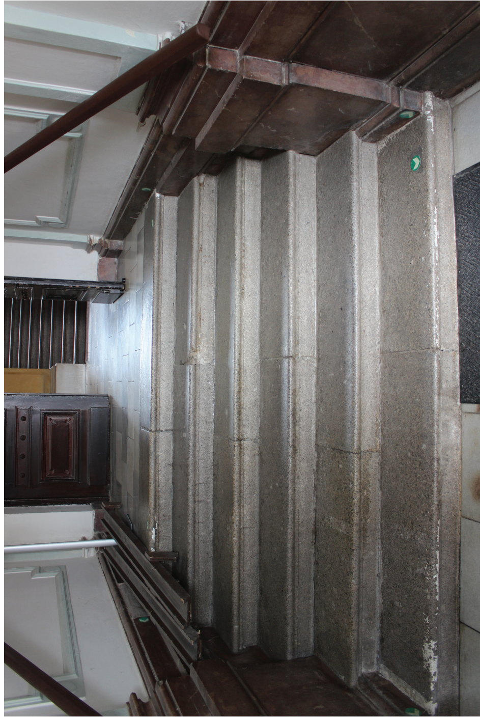
10. Schodiště vstupního vestibulu
