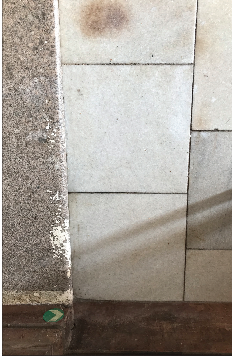
25. Zkouška čištění mramorové dlažby vstupního vestibulu teplou vodní párou s detergenty a mechanickým dočištěním, odstranění rezavých skvrn a nečistot
