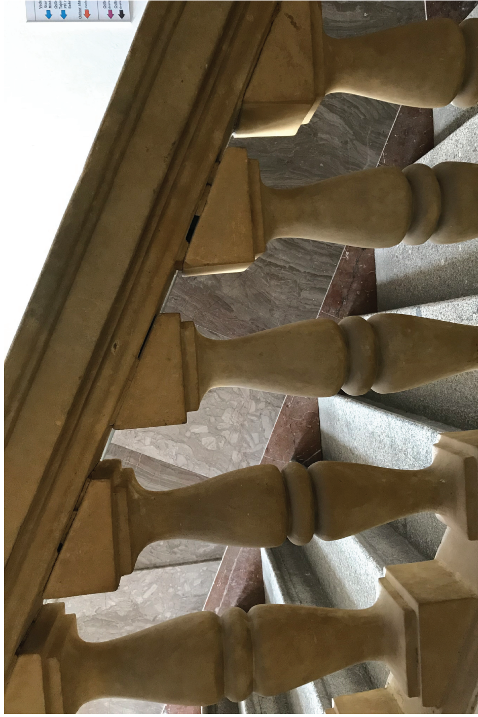
18. Uvolněné kuželky balustrády, částečně vypadané spárování v horní části
