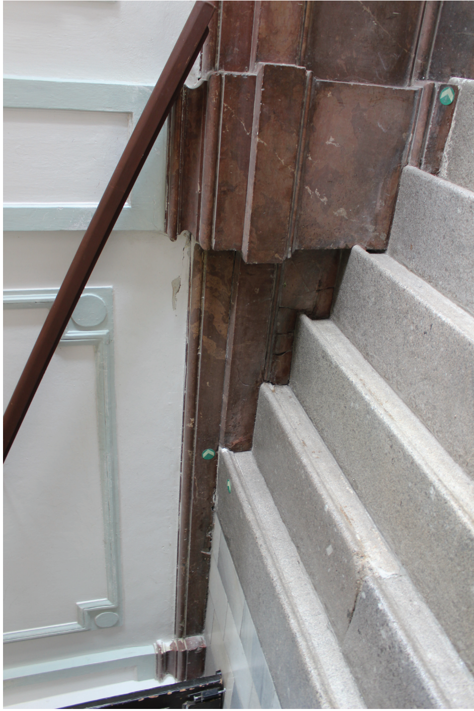
7. Pravá strana vstupního vestibulu, celkový pohled na obklad a částecně tažené prvky z umělého mramoru
