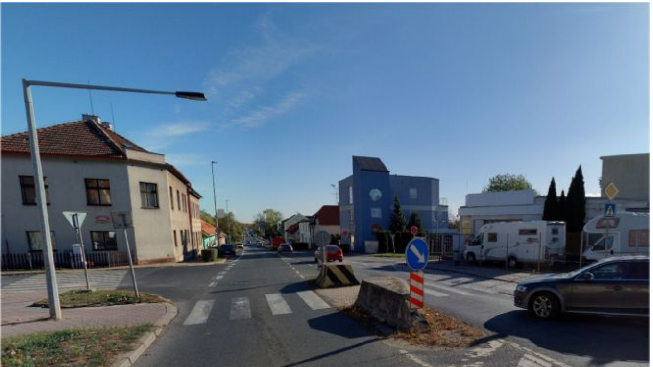
Středový ochranný ostrůvek s přechodem pro chodce (dočasná, montovaná úprava, deltablok)
