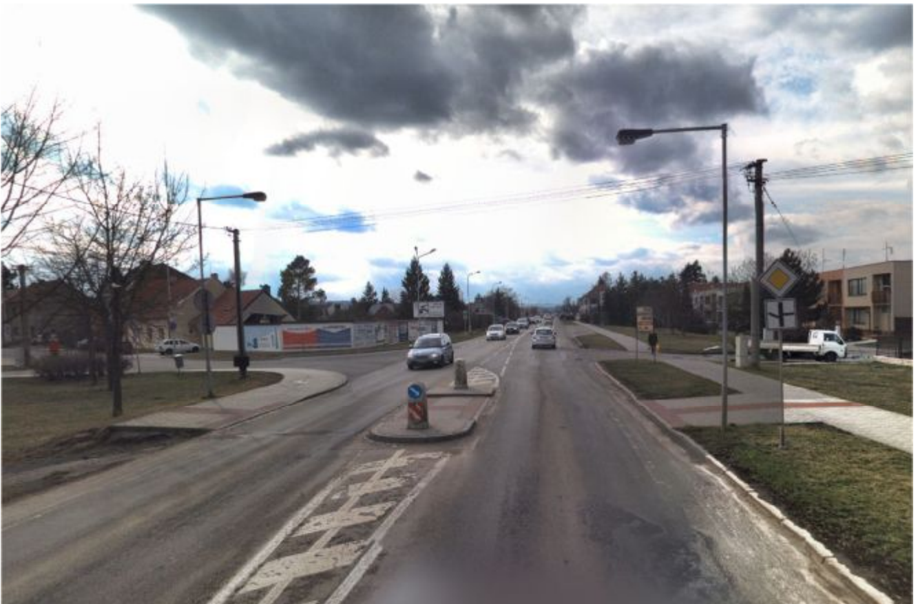
Středový ochranný ostrůvek s přechodem pro chodce (s přisvětlením)
