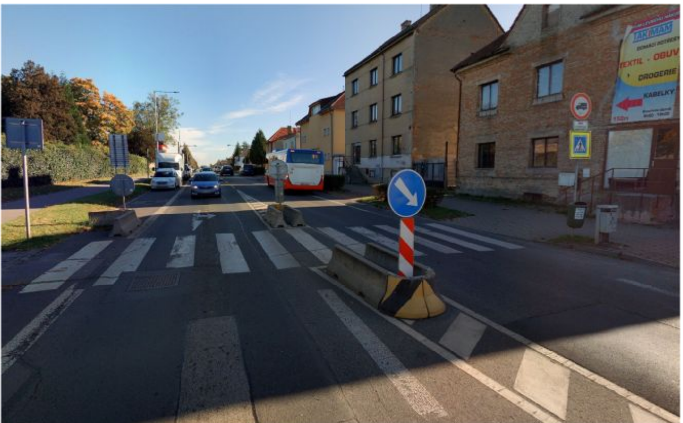
Středový ochranný ostrůvek s přechodem pro chodce (dočasná, montovaná úprava, cityblok)
