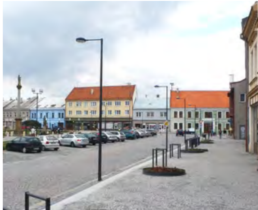
Veřejné osvětlení náměstí v Kojetíně.
