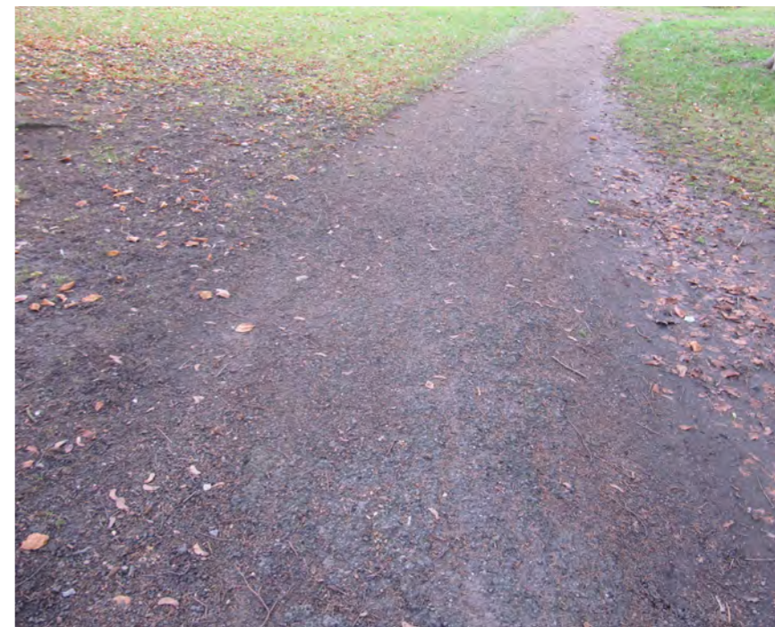
Mechanicky zpevněné kamenivo.
