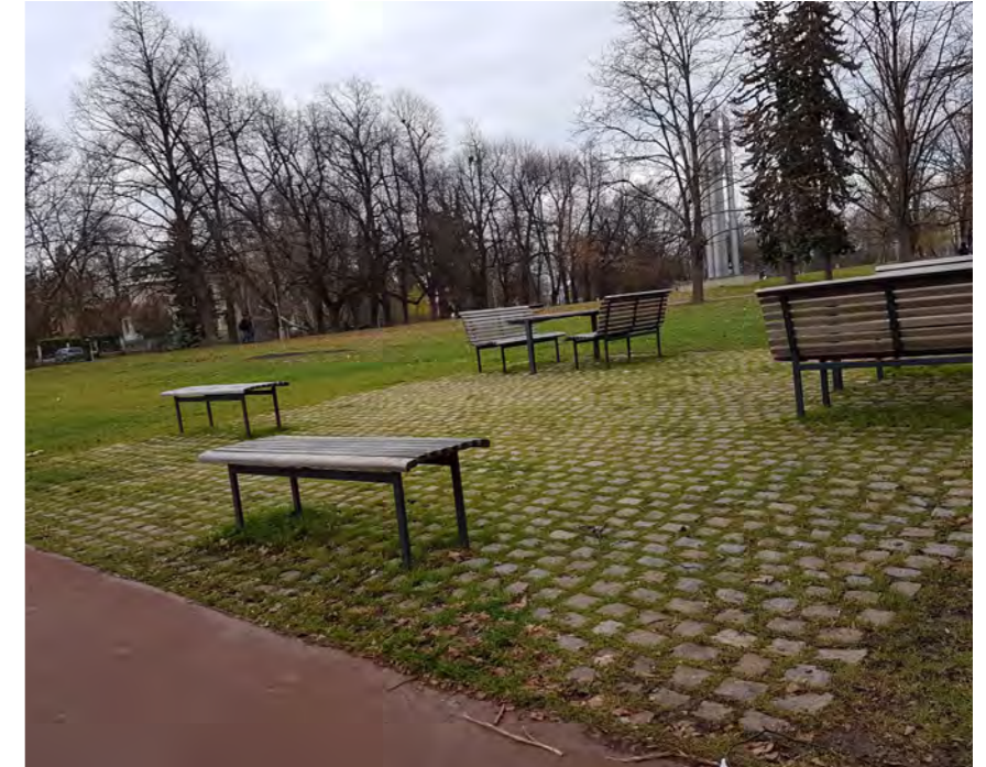
Žulová dlažba se zatravněnými spárami
