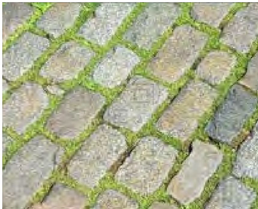
Pojezdová dlažba se zatravněnými spárami.
