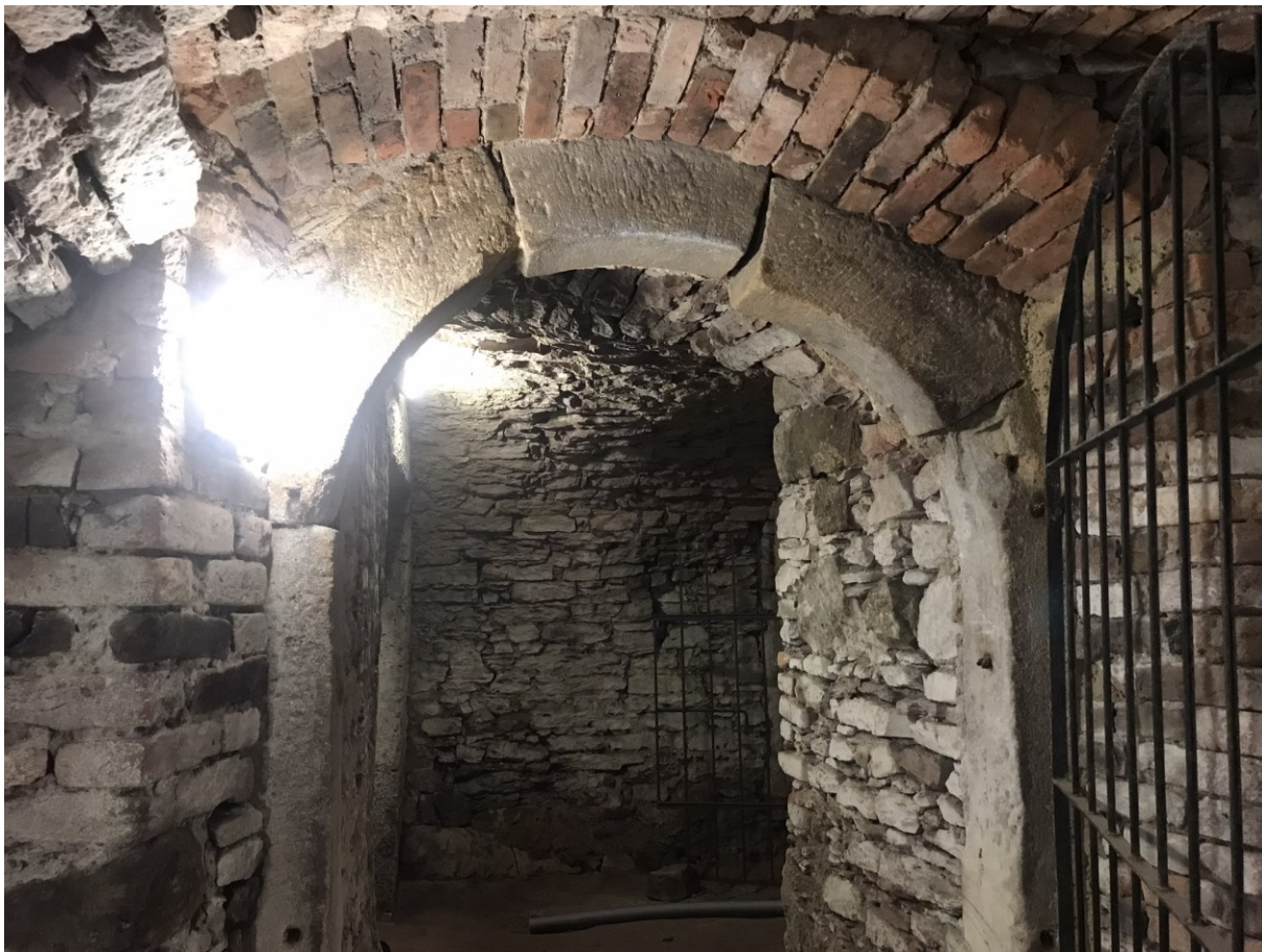
1. Vstupní portál, pohled směrem z odpočívadla prvního ramene schodiště ze síně v podzemí
