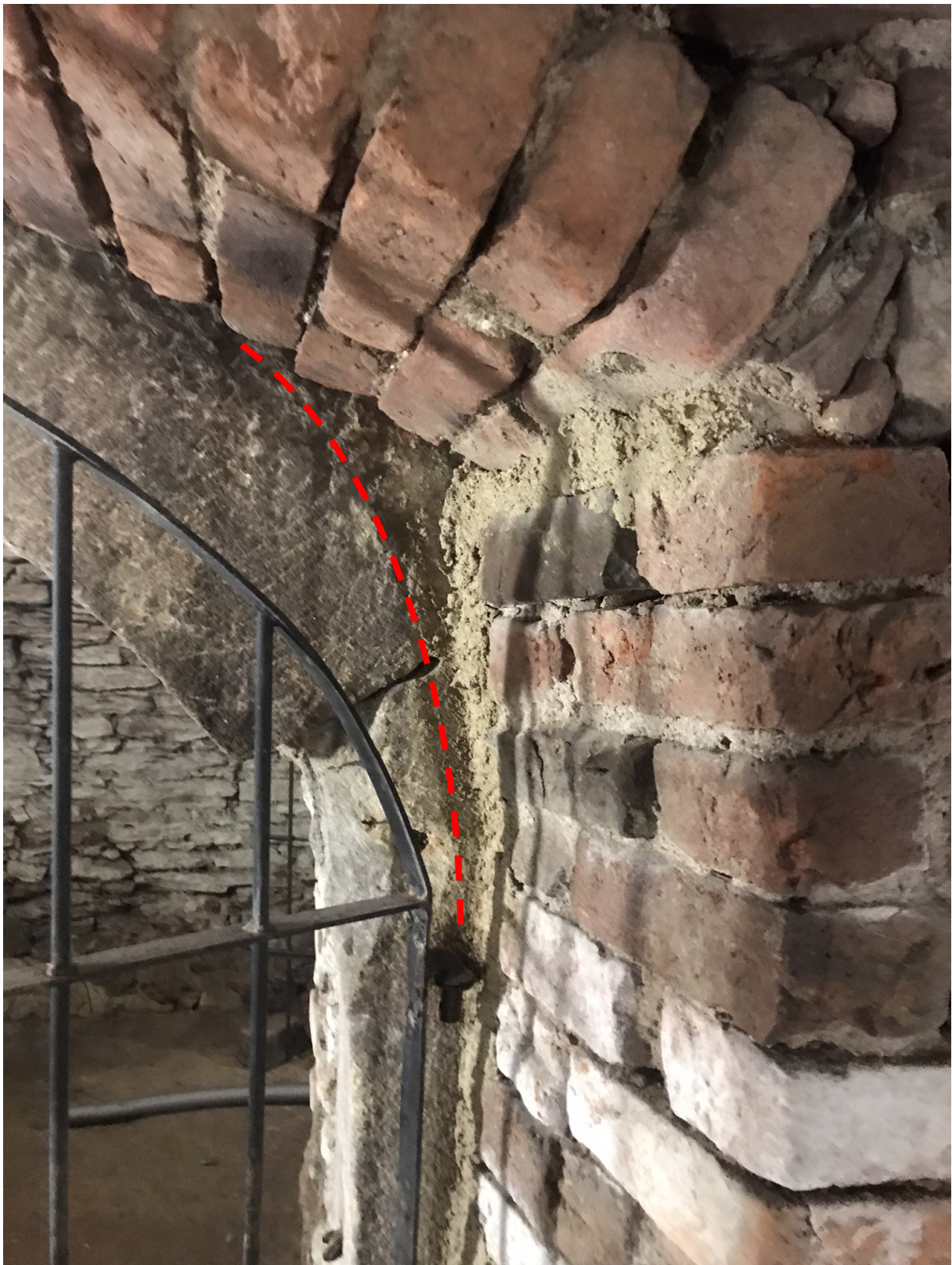
4. Navržený průběh klenby po novém přezdění přesazené cihlové klenby
