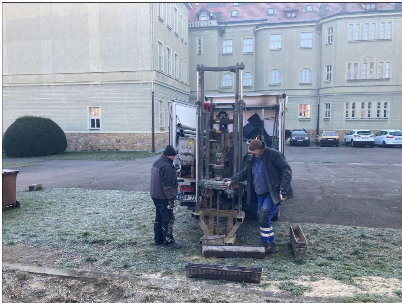
Obrázek č. 3: Fotodokumentace provádění vrtané sondy J-1
