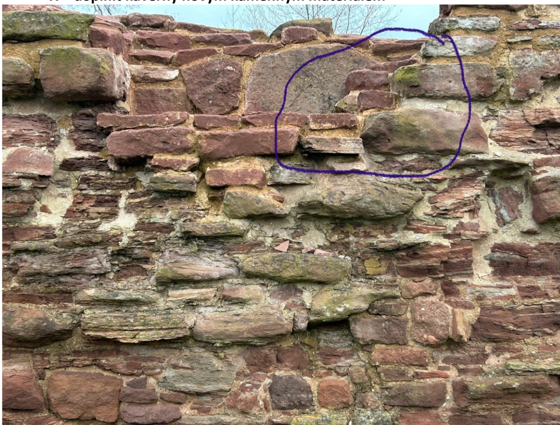
V kurtina – rubová strana zdiva, střílna – upravit špaletu dle vzoru protější strany
