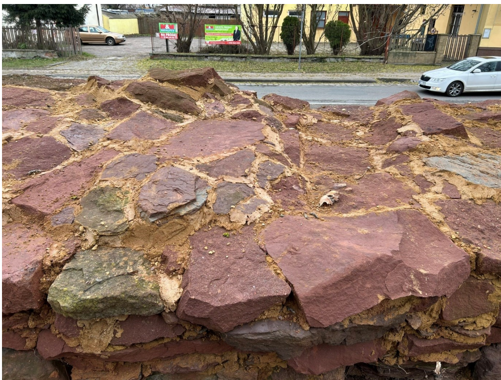
6. J kurtina, detail provedení koruny zdiva
