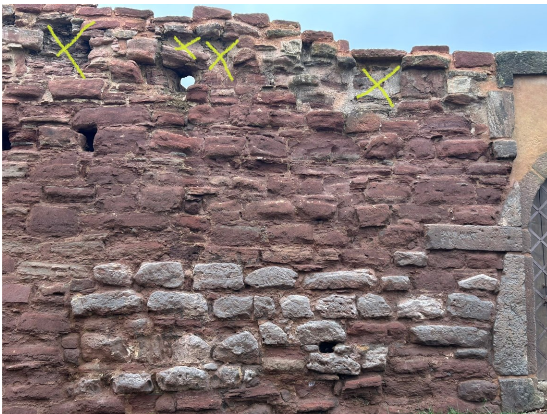
X – doplnit kaverny novým kamenným materiál
