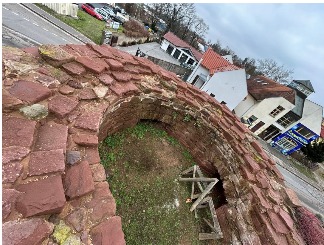
1. Svrchní plocha JV nárožní bašty s novým překryvem pískovcem Nowa Ruda, bez výraznějších poškození.
