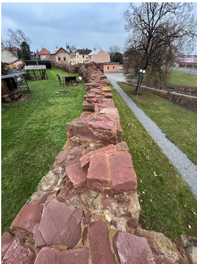
4. V kurtina, pohled na korunu zdiva směrem severu, kromě parapetů střílen bez poškození
