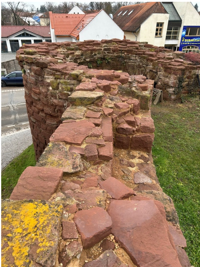
2. Navazující V kurtina s fragmenty střilen
