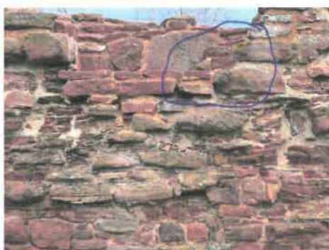
V kurtina – rubová strana zdiva, střílina – upravit špaletu dle vzoru protější strany.
