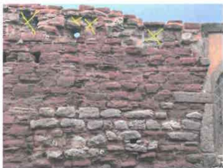
X – doplnit kaverny novým kamenným materiálem.
