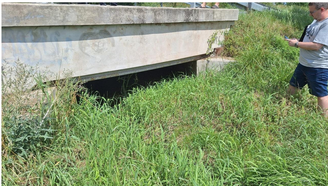
Obrázek 30 Nátoková strana propustku – červenec 2024
