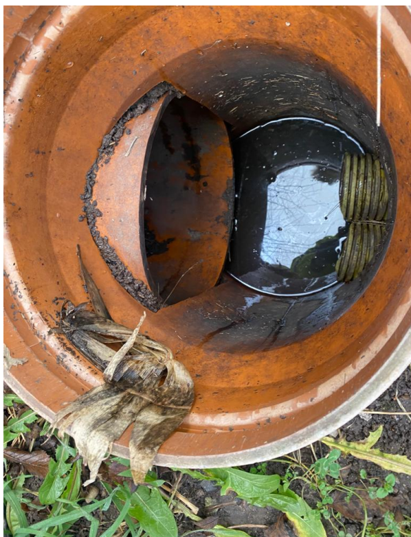
Obrázek 2 Druhá revizní šachta
