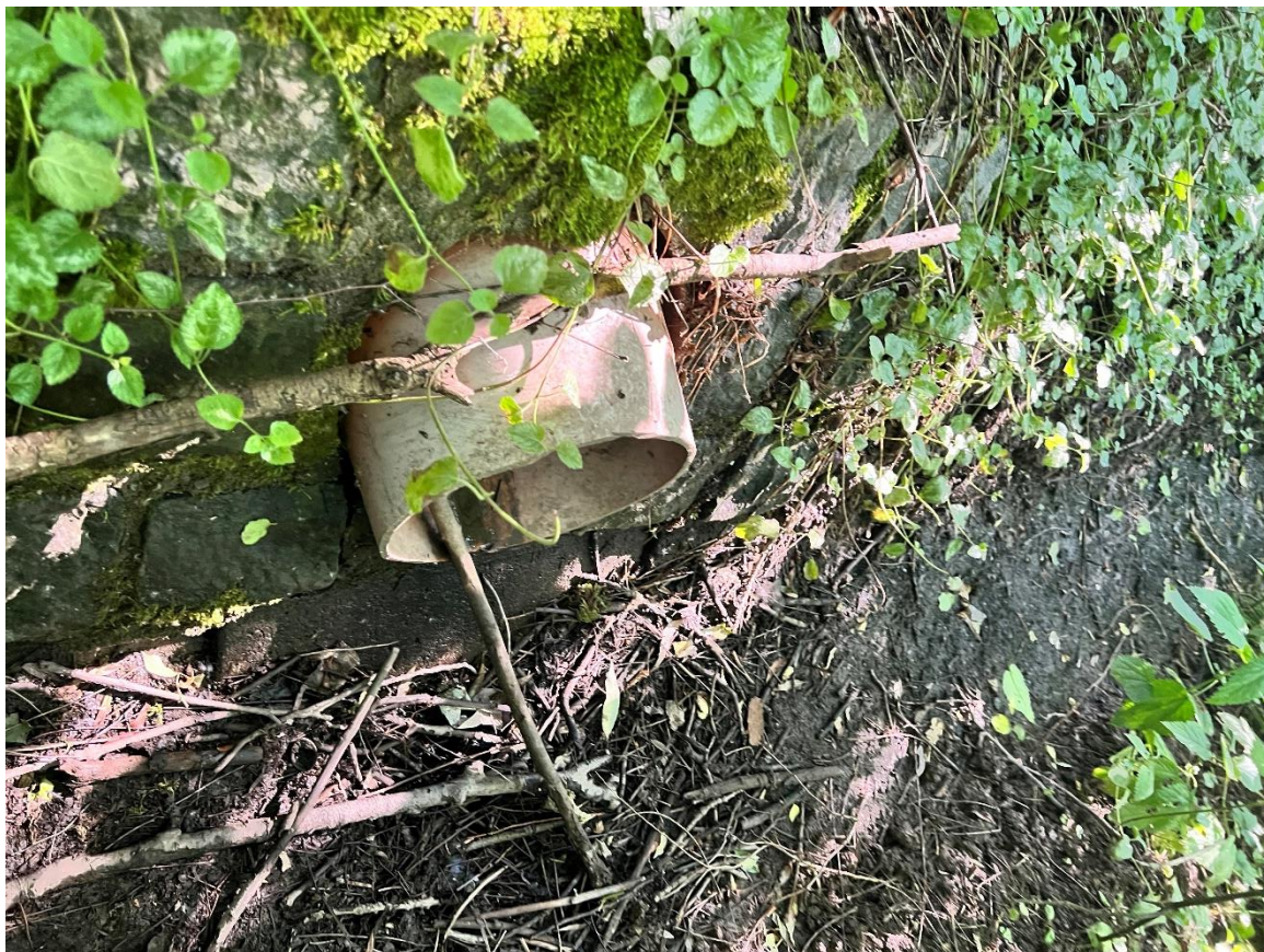
Obrázek 9 Výtok dešťové kanalizace
