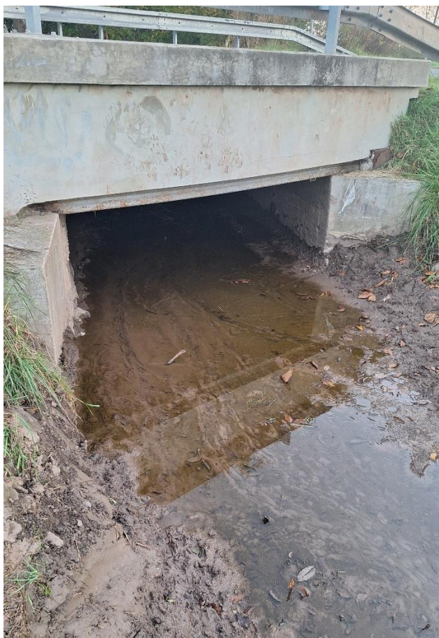
Obrázek 31 Nátoková strana propustku – říjen 2024
