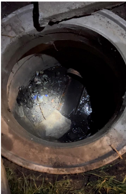
Obrázek 5 Revizní šachta v zahradě č.p. 293
