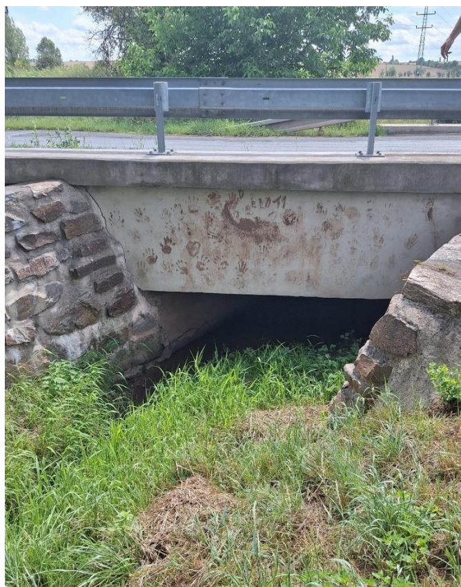
Obrázek 32 Výtoková strana propustku – červenec 2024
