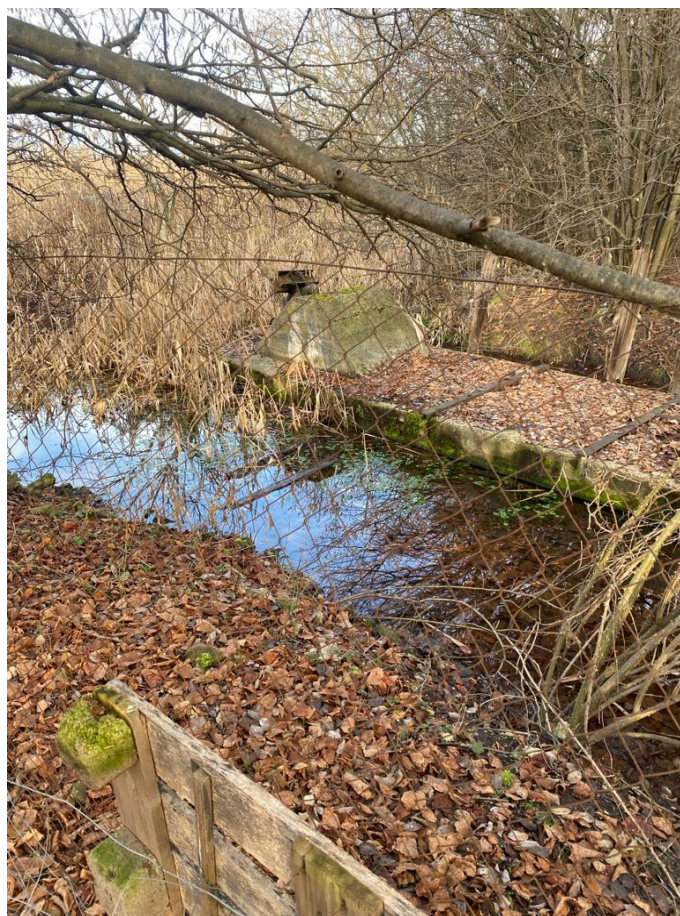
Obrázek 3 Výtok dešťové kanalizace
