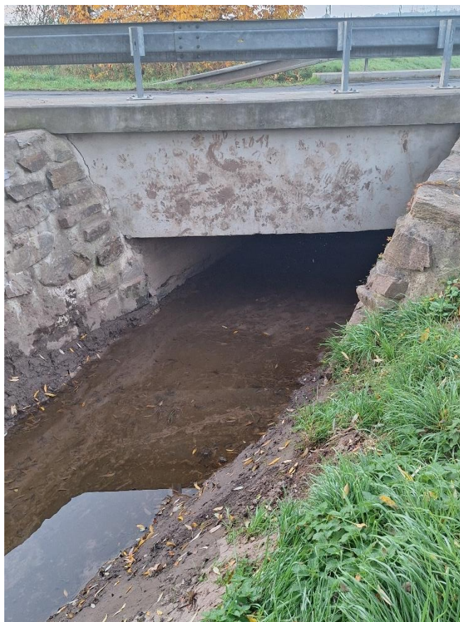
Obrázek 33 Výtoková strana propustku – říjen 2024
