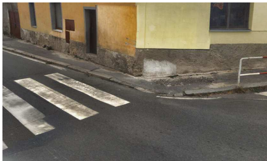
Obr. 5: Nevyhovující průchozí šířka, snížená obruba a chybící vodící pás pro nevidomé
