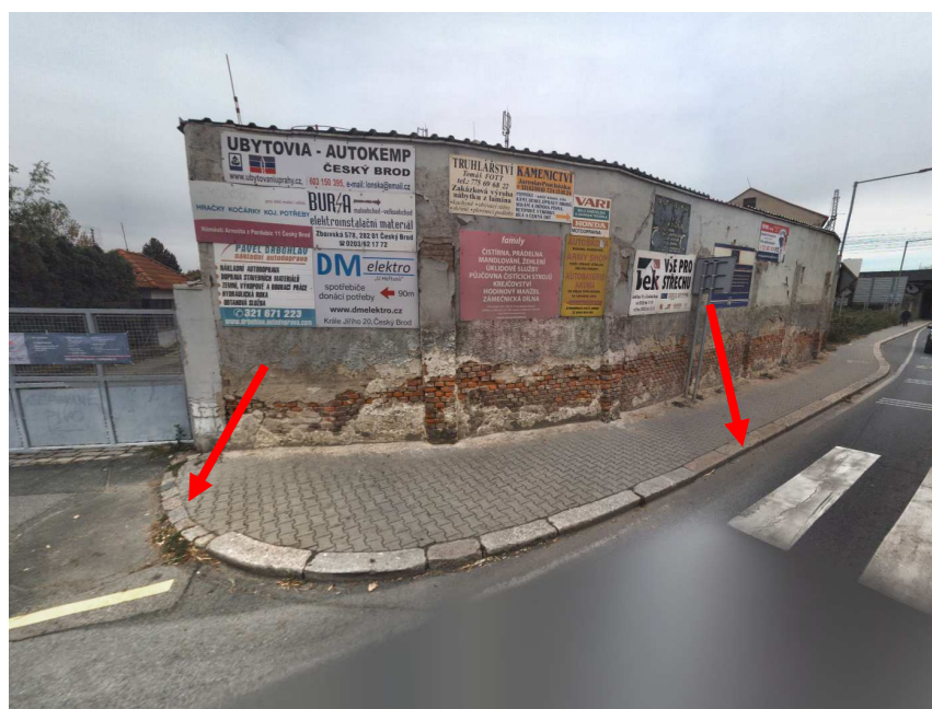
Obr. 20: Chodníkové hrany, kde chybí bezbariérové řešení
