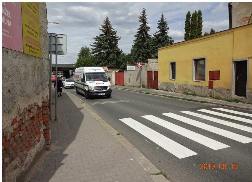
Obr. 13: Nesnížená obruba nástupní plochy chodníku
