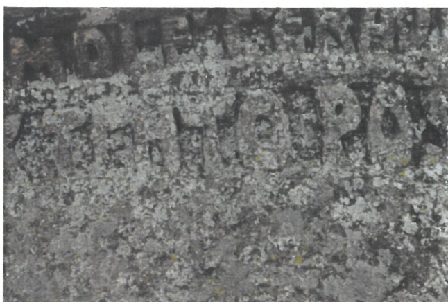
obr. 2 povrch pokrytý biologickými povlaky
