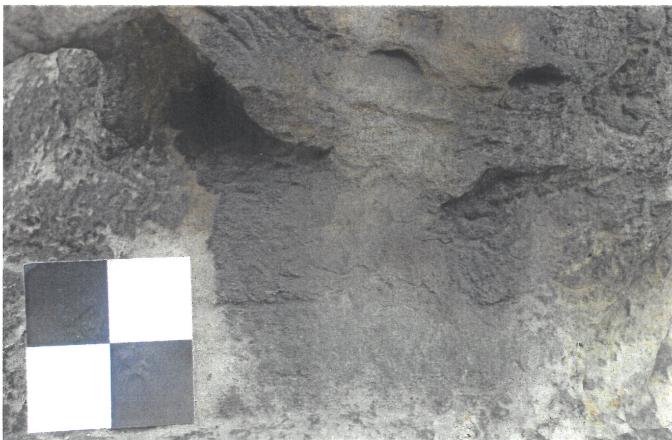
10. Detail sádrovcových krust v podhledech modelace, blok PC/2
