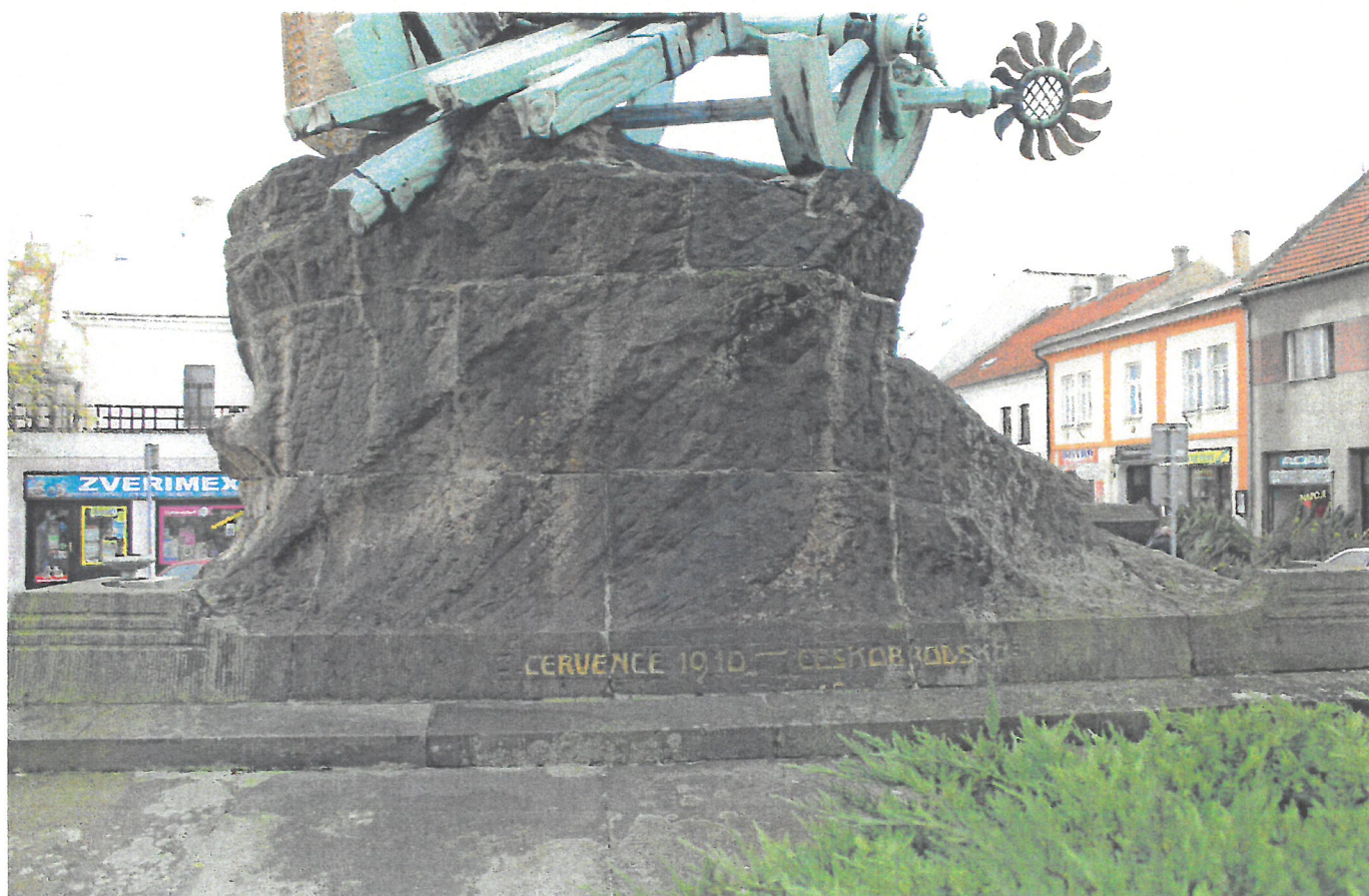
8. Detail podstavce, znečištění kamene měděnkou a přikrytí sádrovcovými krustami
