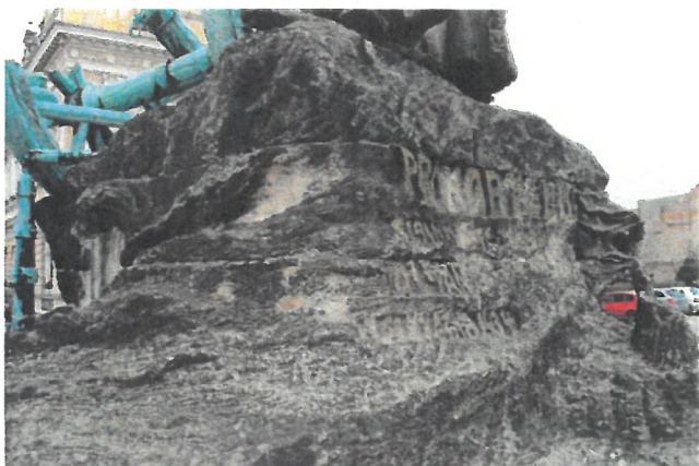
obr. 3 tmavé depozity na svrchních plochách kamene
