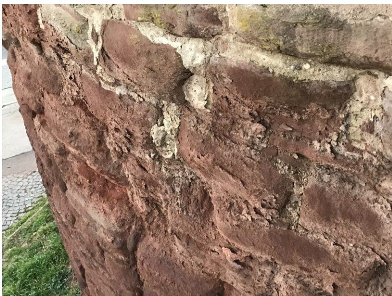
Foto 1/Silně degradovaný kámen horní třetiny zdiva nárožního bastionu
