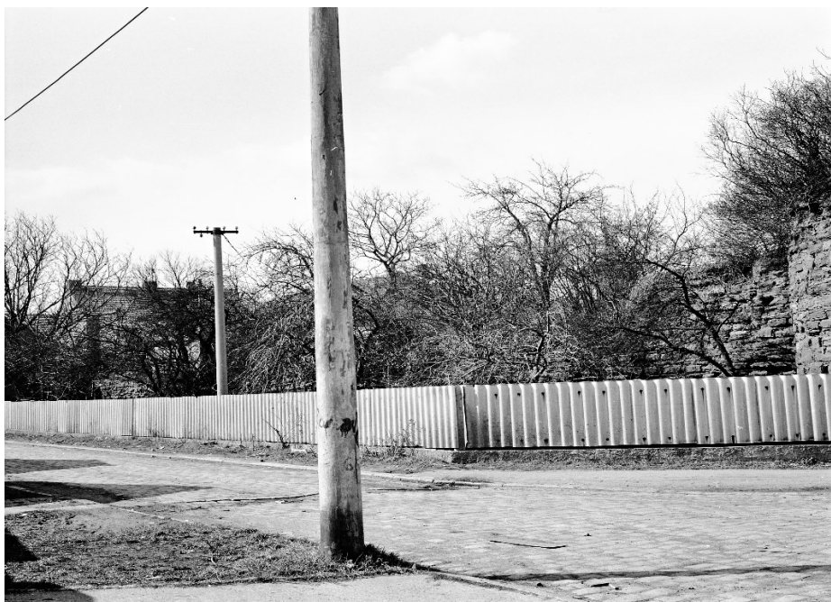
Obr. 2. Pohled na zpracovávaný usek městského opevnění od JV nárožní bašty směrem ke Kouřimskému předbraní, stav v roce 1987, archiv NPU, ÚOP středních Čech
