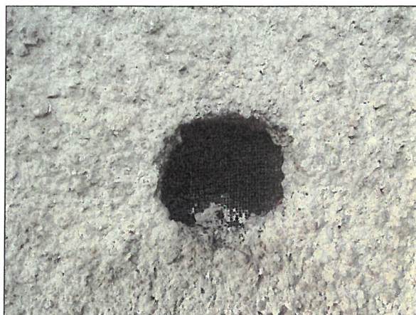
č. 17 Pavilon F, východ, detail VO s funkční kovovou sítkou
