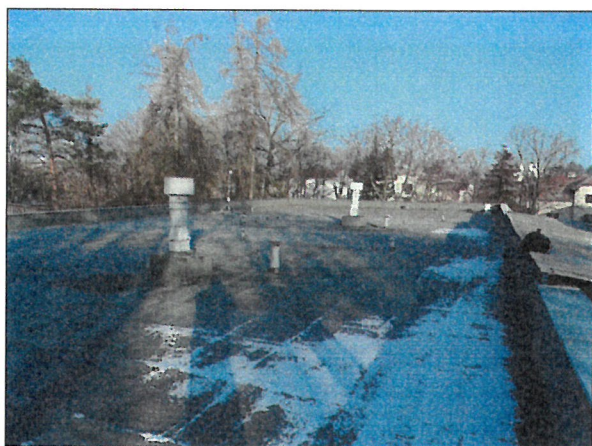
č. 14 Pavilon F, pohled na plochu střechy
