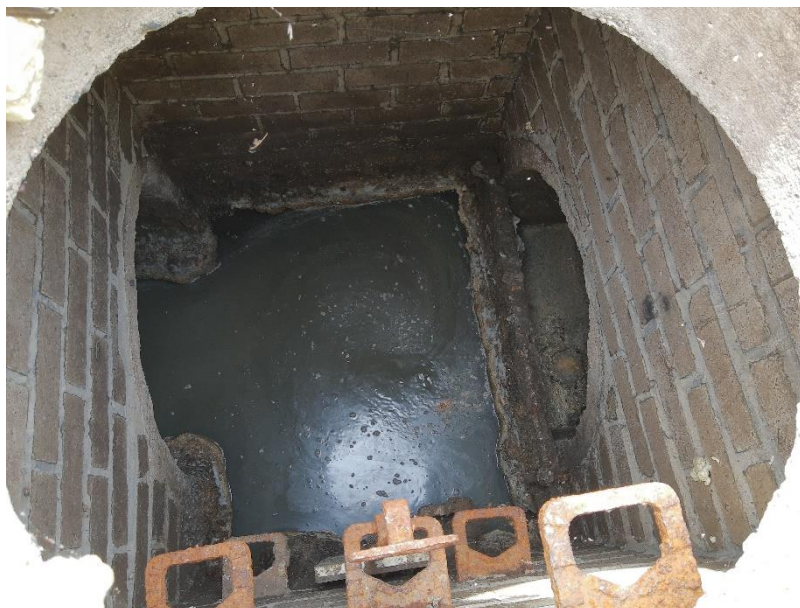
Obr. 1 Odlehčovací komora OK10 (fotodokumentace z terénního průzkumu)
