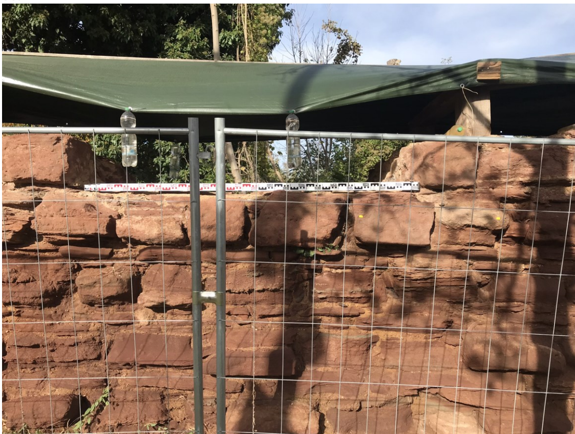
4. Sekundárně vzniklá kapsa při etapě demontáže narušeného zdiva
