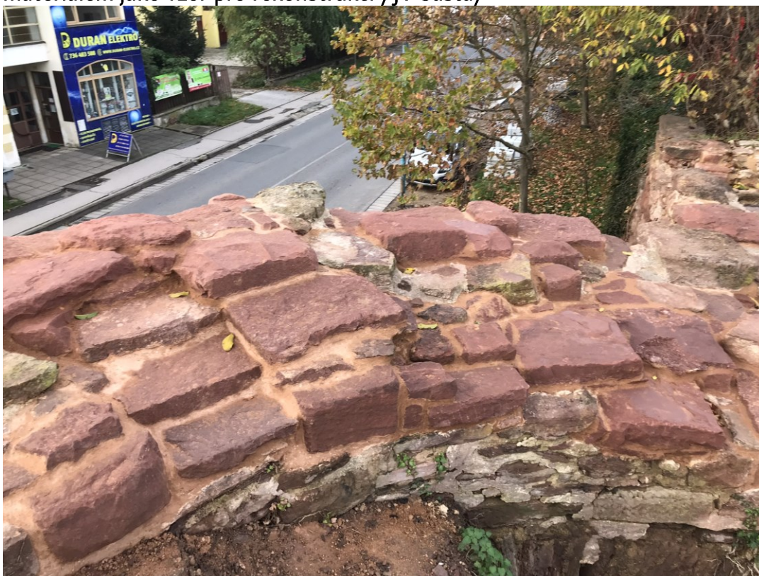
2. Příklad ztvárnění koruny zdiva v navazujícím úseku. JV nárožní bašta.
