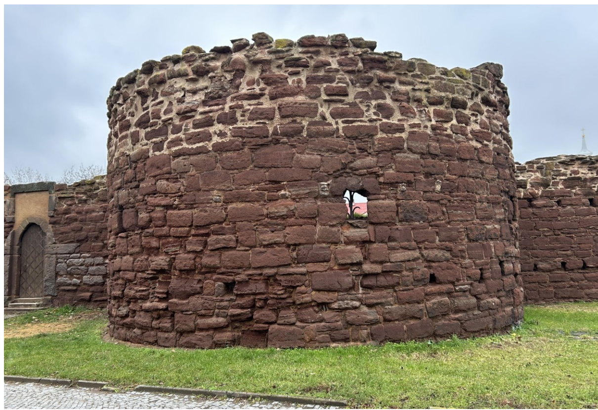
V horní třetině provést v lícové svislé ploše odstranění malty spár, spáry poté vyplnit převážně drobným úlomkovým materiálem kladeným do malty
