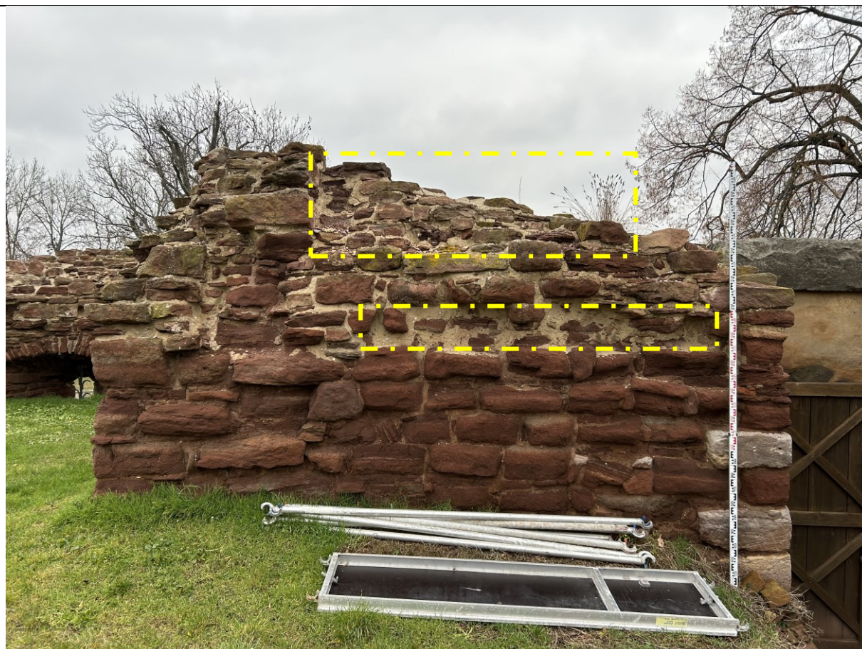
Vyznačení příkladu míst k doplnění zdiva z většího formátu kamene
