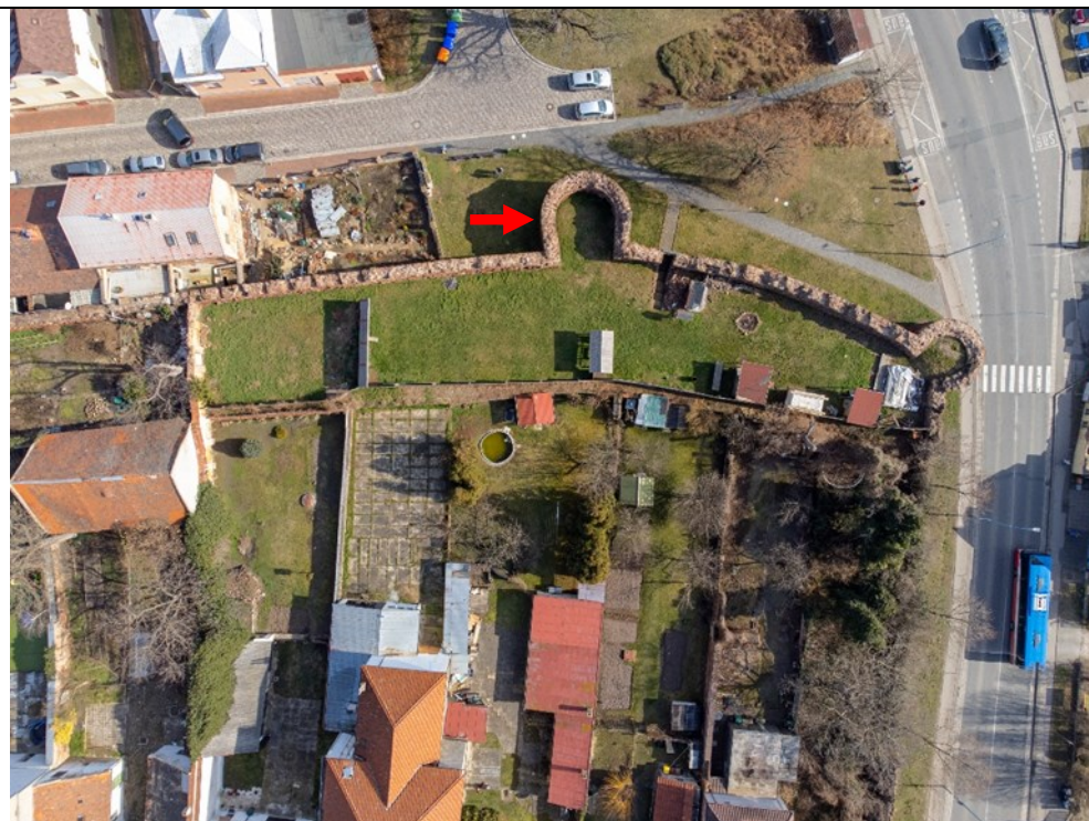
Český Brod, torzo fortifikace města, V bašta, lícová strana zdiva, fotodokumentace stavu
