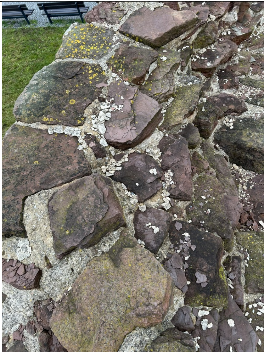
Český Brod, torzo fortifikace města, V bašta, svrchní plocha, poškození malty spár, fotodokumentace stavu
