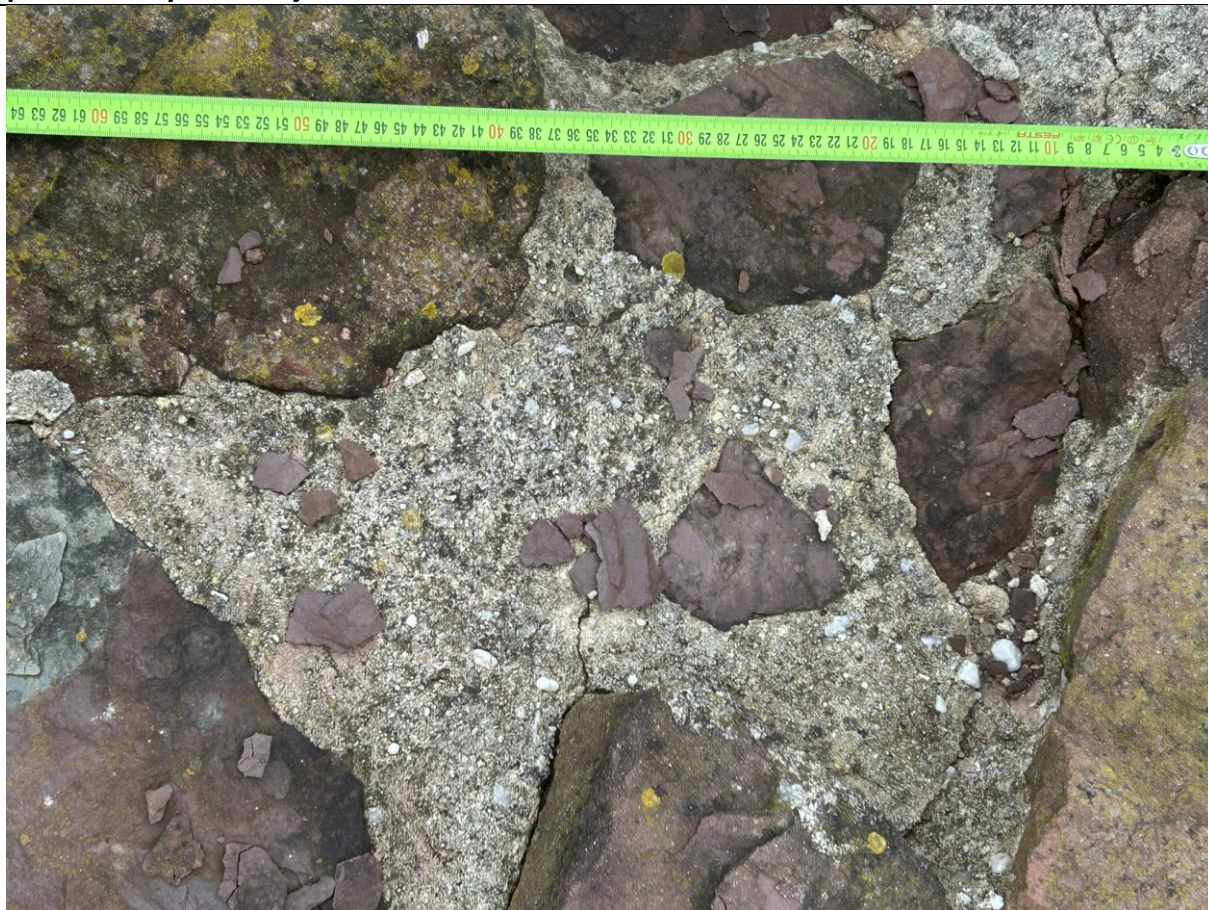
Český Brod, torzo fortifikace města, V bašta, svrchní plocha, příklad poškození větších ploch omítky nahrazujících kamennou hmotu
