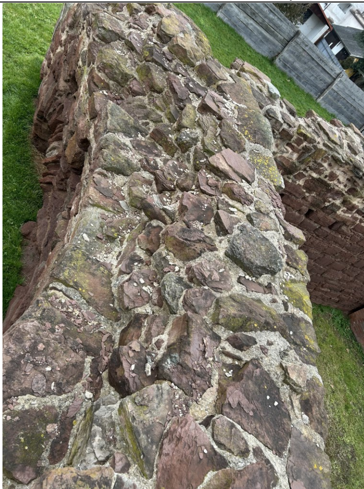
Český Brod, torzo fortifikace města, V bašta, svrchní plocha zdiva, fotodokumentace stavu
