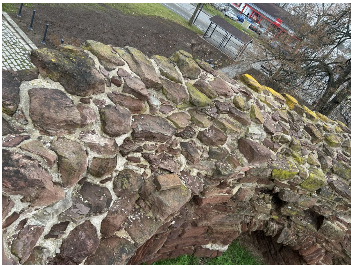
Český Brod, torzo fortifikace města, V bašta, svrchní plocha zdiva, fotodokumentace stavu
