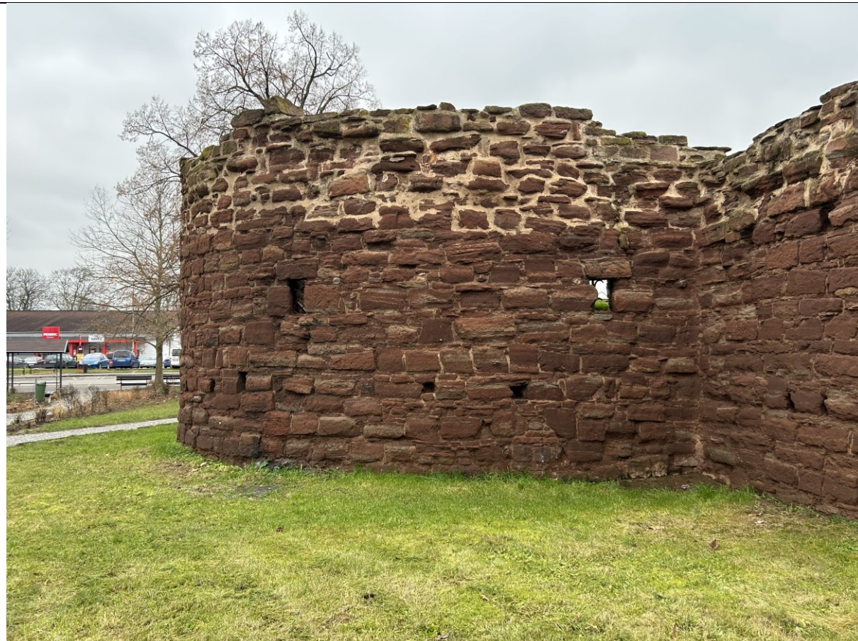
V horní třetině provést v lícové svislé ploše odstranění malty spár, spáry poté vyplnit převážně drobným úlomkovým materiálem kladeným do malty
