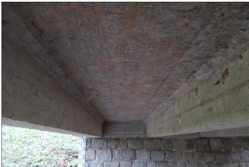
podhled desky mostovky od levobřežní opěry O1 mezi 1. a 2. trámem zleva
