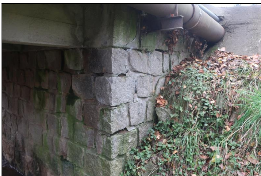
levé křídlo levobřežní opěry O1
