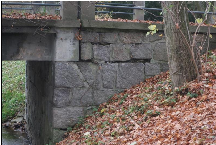
pravé křídlo pravobřežní opěry O2
