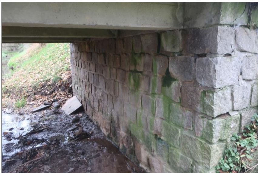
pohled na dřík levobřežní opěry O1 zleva
