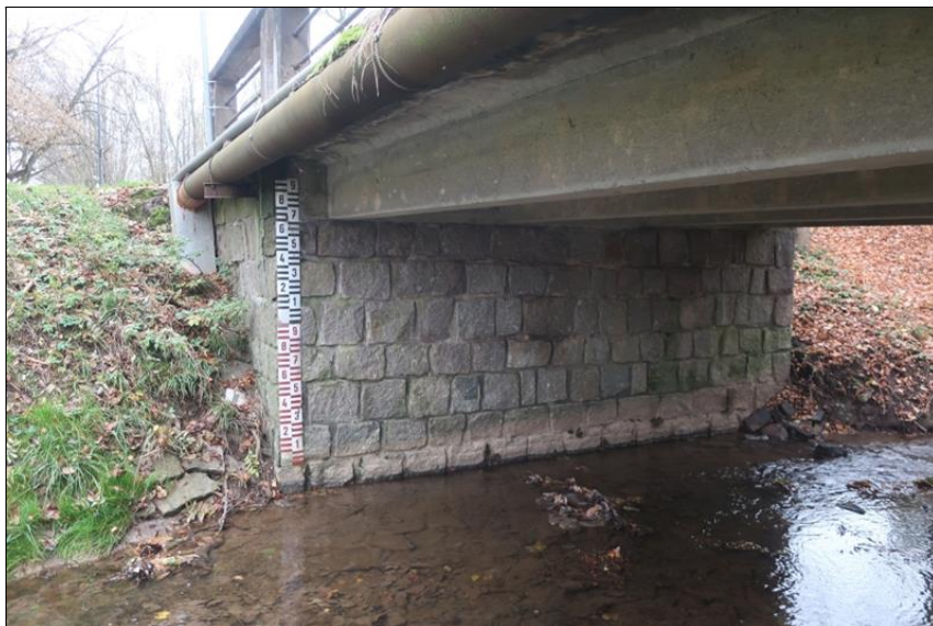
pohled na dřik pravobřežní opěry O2 zleva
