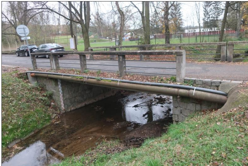
pohled na levou stranu mostu
