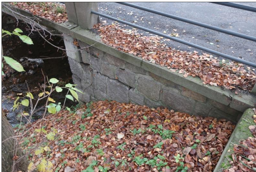
pravé křídlo pravobřežní opěry O2
