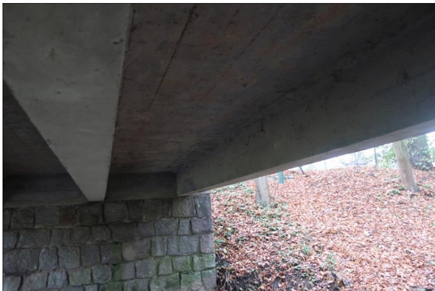
podhled desky mostovky od levobřežní opěry O1 mezi 3. a 4. trámem zleva
