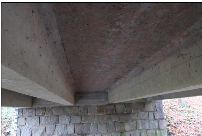
podhled desky mostovky od levobřežní opěry O1 mezi 2. a 3. trámem zleva
