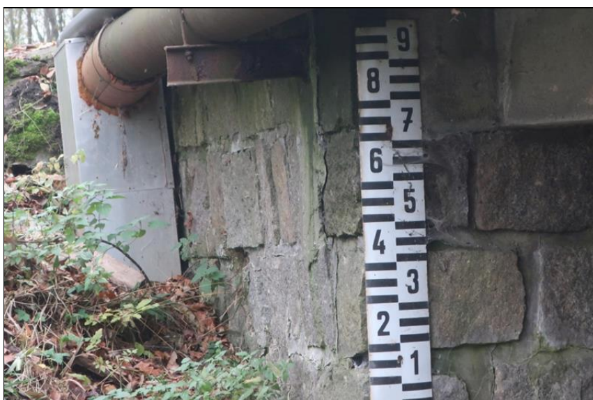
levé křídlo pravobřežní opěry O2
