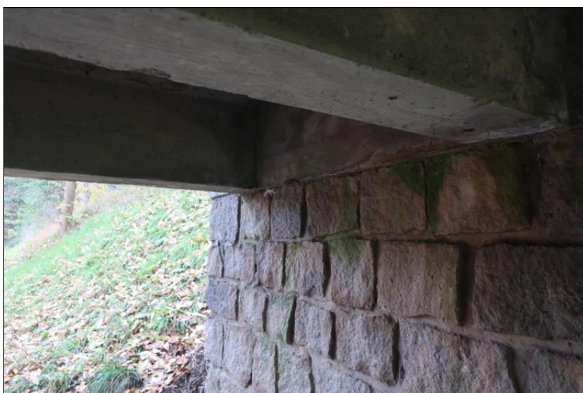
uložení trámového roštu na levobřežní opěru O1
