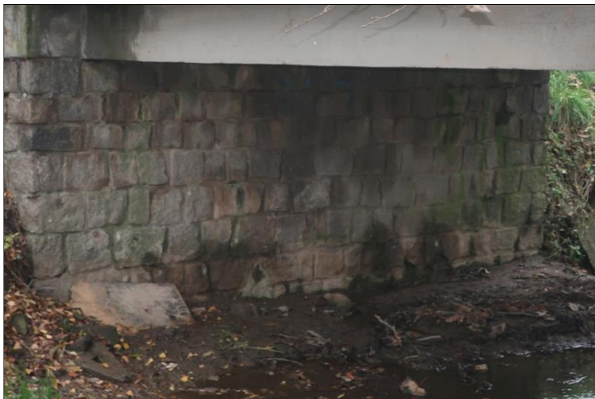
pohled na dřík levobřežní opěry O1 zprava
